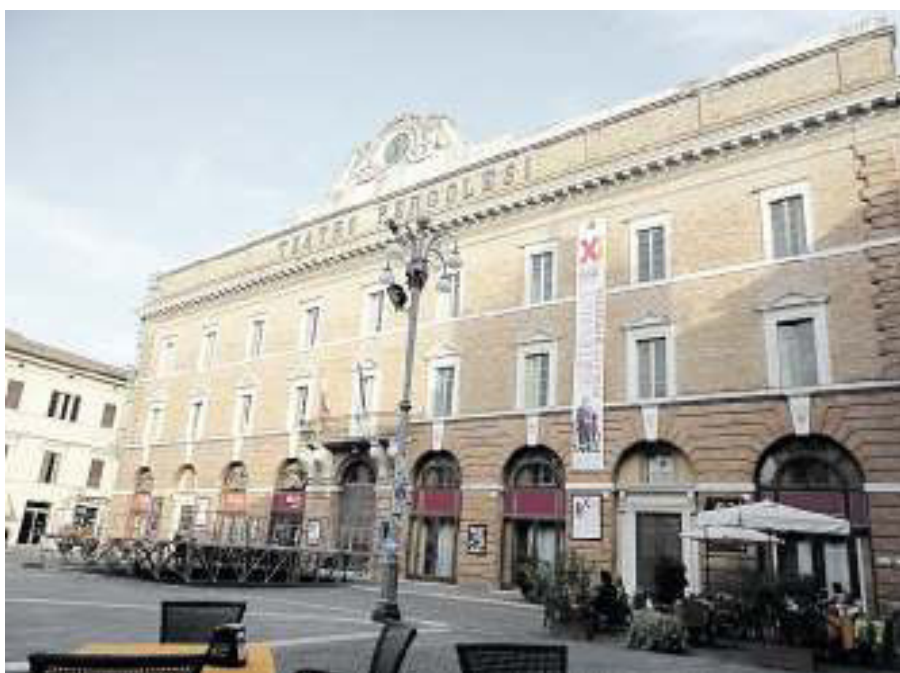
Verrà riparata la fognatura che causa le infiltrazioni al Pergolesi
